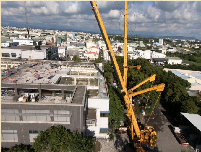
運動場切割拆除
