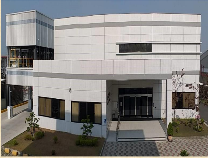
奇美廠房新建工程
