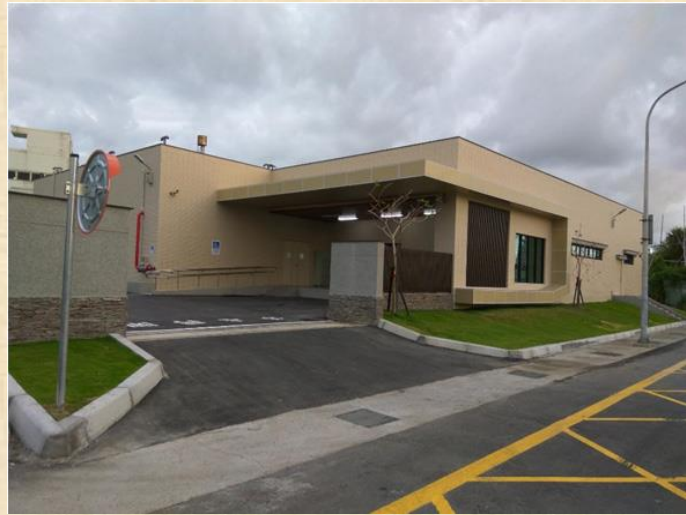
奇美實業廚房新建工程
